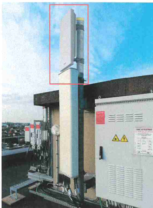
Vue de la terrasse S0 après travaux
