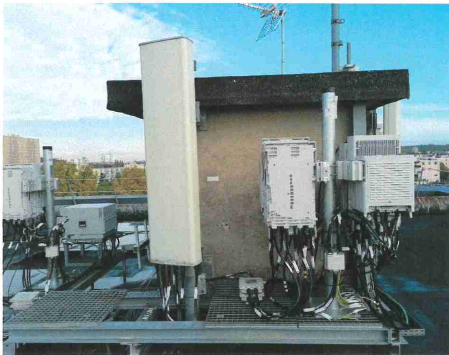
Vue de la terrasse S1 avant travaux
