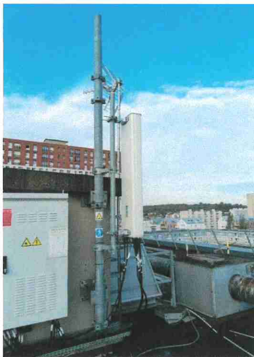
Vue de la terrasse S2 avant travaux
