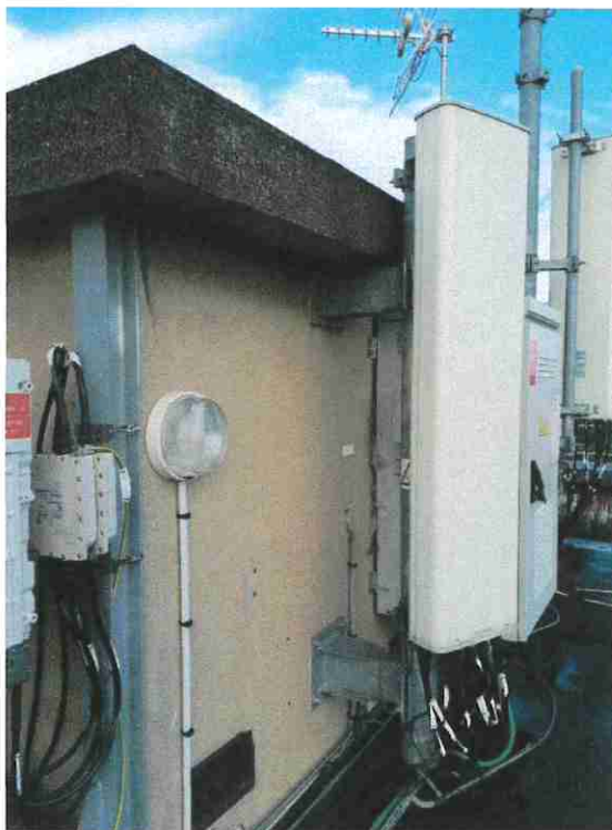
Vue de la terrasse S0 avant travaux
